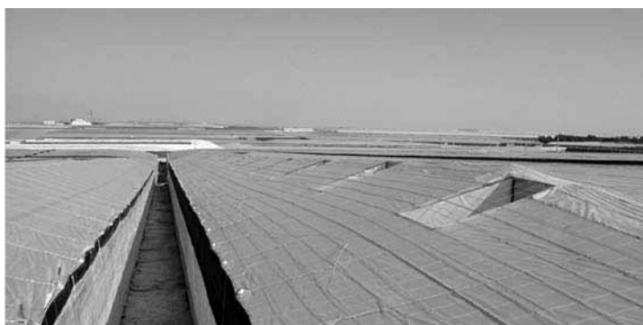
Figura 55. Vista exterior de una instalación de ventilación forzada en un invernadero Almería con las salidas de aire de los extractores situadas sobre la cubierta
