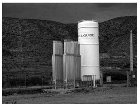
Figura 100. Depósito de \text{CO}_2 y circuitos del evaporador para enriquecimiento carbónico en invernaderos
