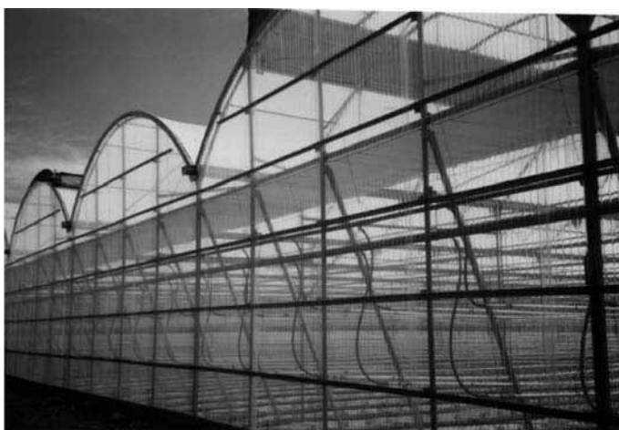
Figura 38. Invernadero multitúnel con recubrimiento frontal de policarbonato
