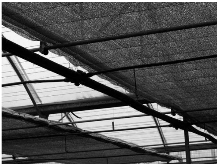
Figura 93. Pantalla térmica de doble cara aluminizada
