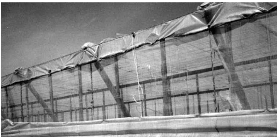
Figura 40. Bandas laterales deslizantes con sistema de cuerda y polea
