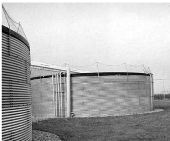
Figura 88. Depósitos calorifugados para el almacenamiento de agua caliente para calefacción de invernaderos en Holanda
