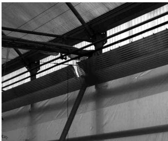
Figura 95. Pantalla de oscurecimiento en el lateral de un invernadero
