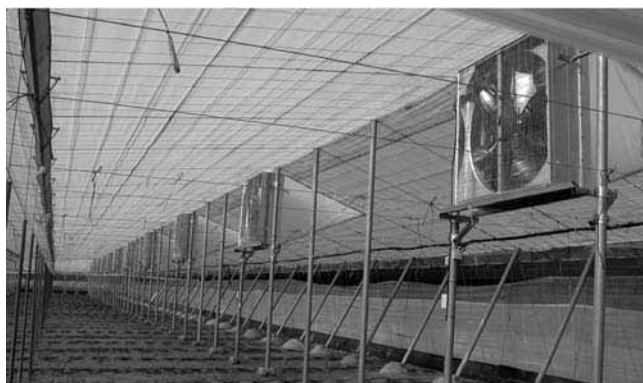
Figura 54. Conjunto de extractores en el lateral de un invernadero tipo Almería. La separación entre los centros de los dos extractores es de 8 m
