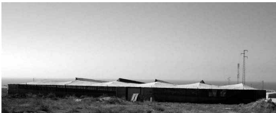
Figura 22. Invernadero tipo Almería en su variante raspa y amagado
