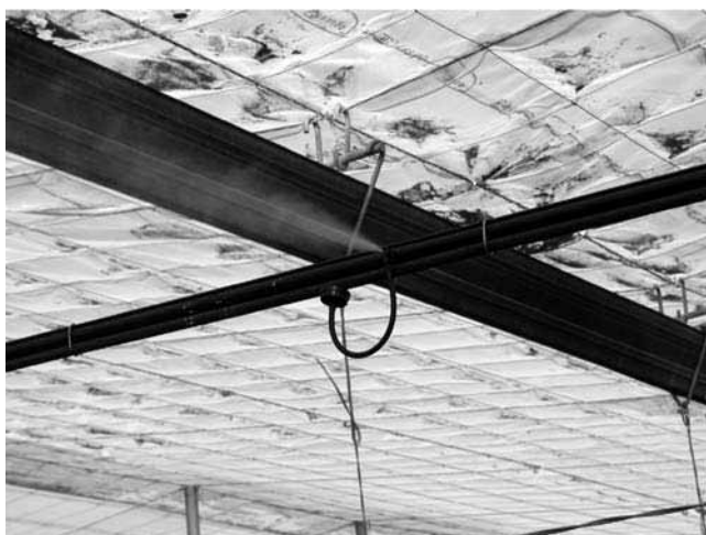
Figura 65. Detalle de una boquilla de nebulización por aire comprimido en un invernadero tipo Almería
