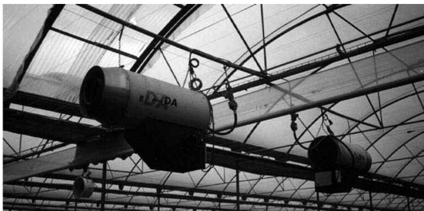
Figura 67. Generadores de aire caliente de combustión directa
