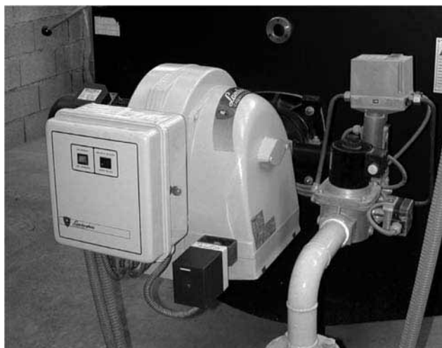
Figura 78. Quemador modulante en una caldera para calefacción de invernaderos
