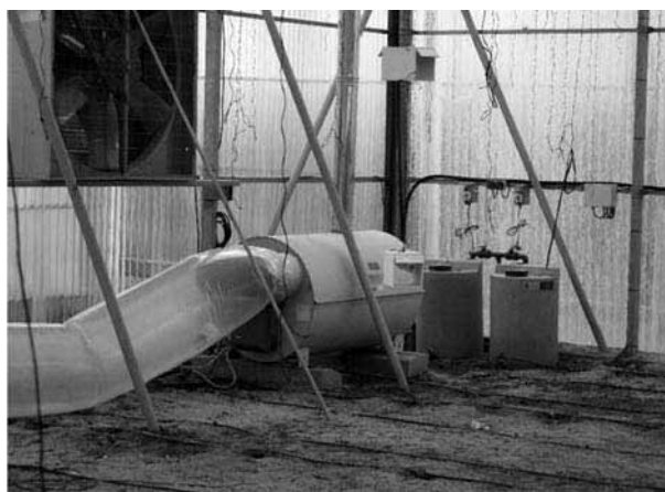
Figura 71. Mangas de polietileno para distribución del aire caliente producido por un generador de combustión indirecta
