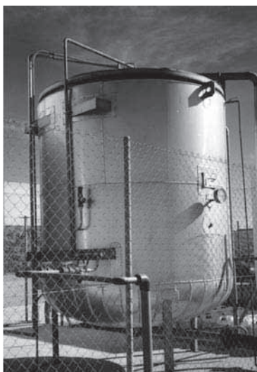
Figura 102. Evaporador de CO 2 con sistema de calefacción auxiliar
