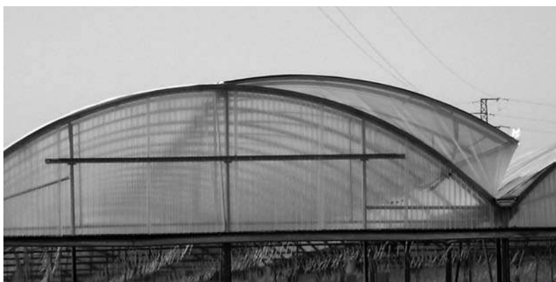
Figura 47. Ventana cenital de invernadero multitúnel de medio arco sobre canal
