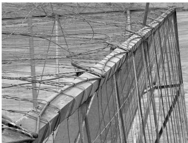
Figura 23. Invernadero en raspa y amagado en construcción
