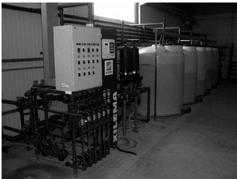
Figura 112. Sistema automatizado de fertirrigación con inyectores Venturi
