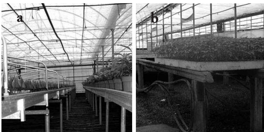
Figura 84. Tuberías de calefacción bajo las bandejas de un semillero apoyadas en el suelo (a) y colgadas de las mesas (b)
