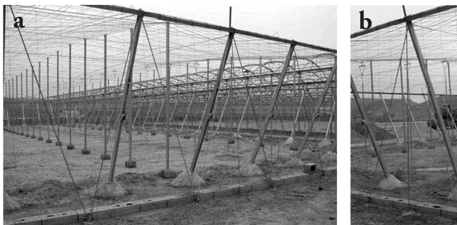
Figura 19. Estructura de la banda lateral de un invernadero tipo Almería con cerco perimetral con ángulos de acero y vientos de acero (a) y detalle de un anclaje directo entre dos vientos (b)
