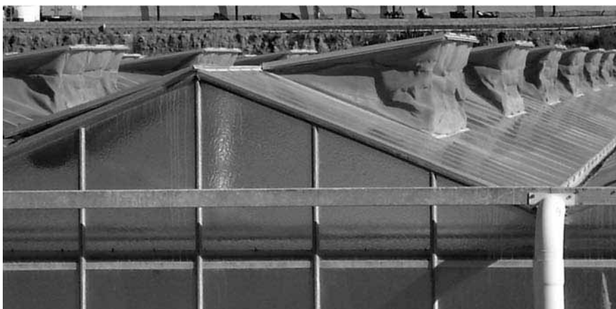
Figura 50. Ventanas alternas en un invernadero venlo construido en Almería
