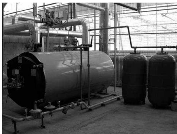
Figura 74. Caldera y vasos de expansión en una instalación por agua caliente en invernaderos de Almería alimentada por gas propano
