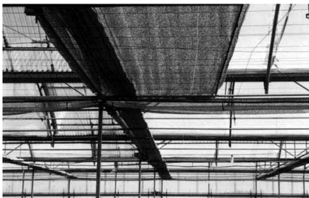
Figura 90. Pantalla térmica suspendida replegada en un sector y en fase de despliegue en el sector contiguo
