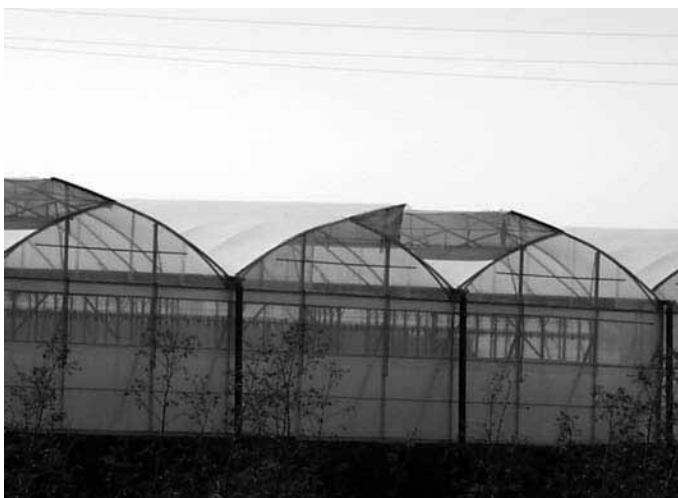
Figura 29. Invernadero multitúnel gótico con ventanas supercentritas en cumbrera
