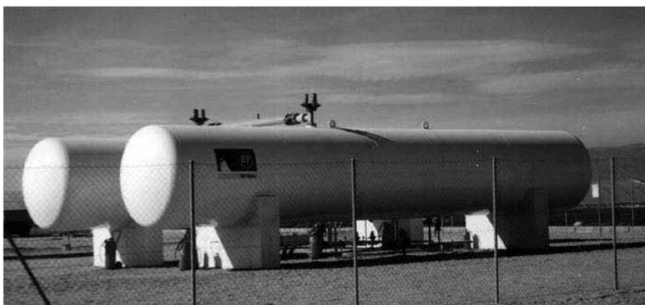
Figura 73. Depósitos de gas propano para una instalación de calefacción
