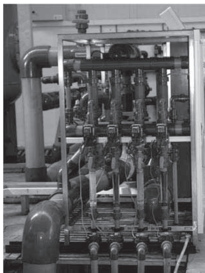
Figura 110. Detalle de los inyectores Venturi en una instalación de fertirrigación
