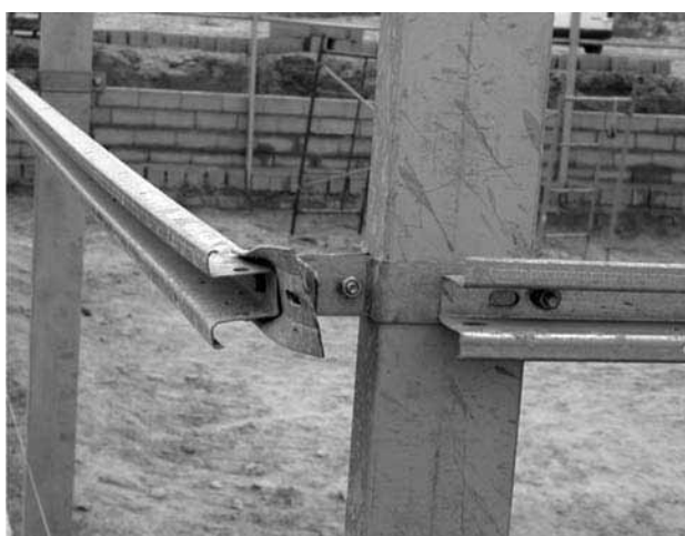
Figura 27. Perfiles para la sujeción del plástico en invernaderos multitúnel
