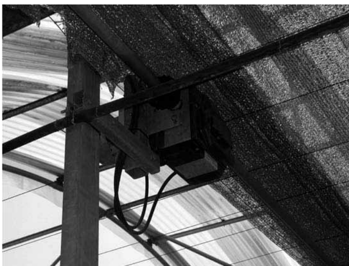
Figura 94. Motorreductor para el accionamiento de las pantallas térmicas suspendidas
