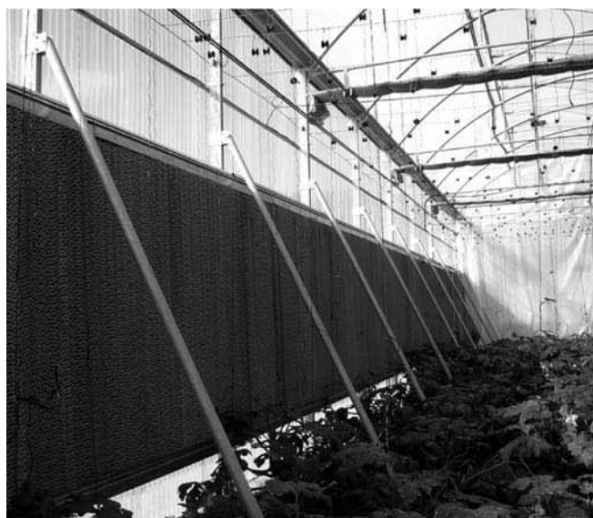
Figura 60. Vista de un panel evaporador de celulosa desde el interior del invernadero
