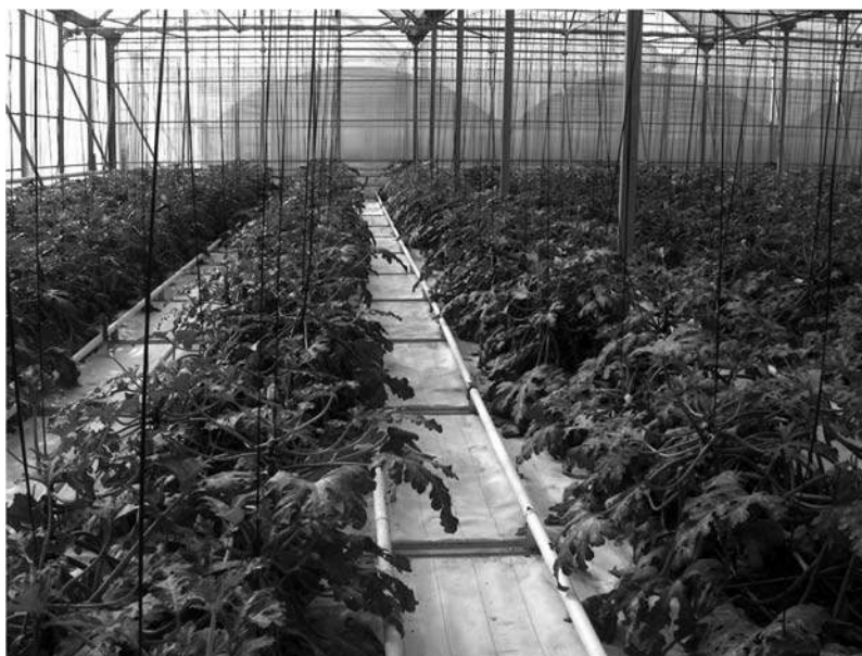
Figura 81. Instalación de calefacción mediante tuberías metálicas de agua caliente
