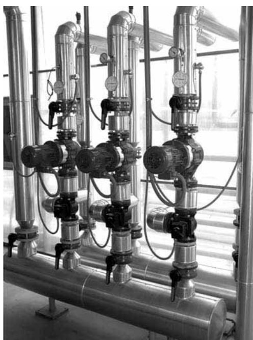
Figura 75. Tuberías principales de un sistema de calefacción de invernaderos con coquilla aislante y válvulas de tres vías para regulación de la temperatura
