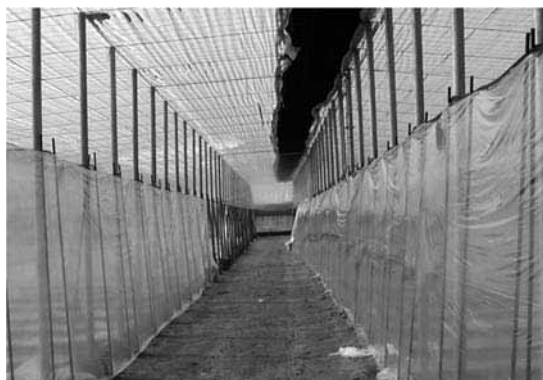
Figura 99. Particiones interiores con láminas de polietileno dentro de un invernadero
