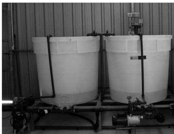
Figura 133. Depósitos con sistema agitador y bombas de impulsión de un sistema de tratamientos fitosanitarios mediante red estacionaria de nebulización
