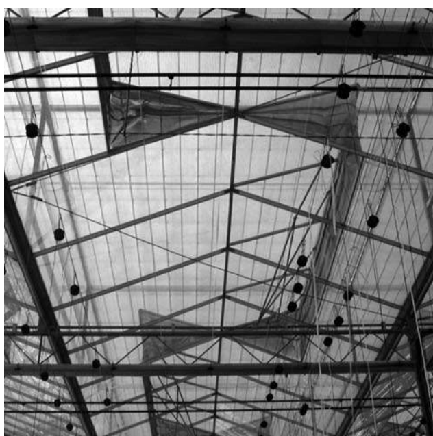
Figura 51. Vista interior de una ventana discontinua en un invernadero venlo
