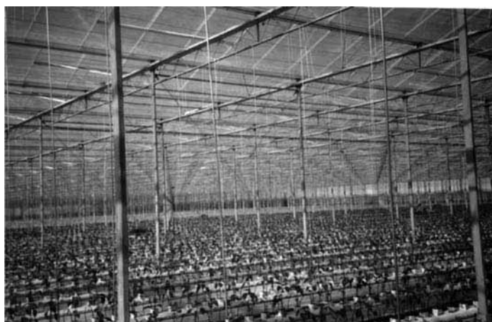
Figura 39. Invernadero tipo venlo con cubierta de cristal en Almería
