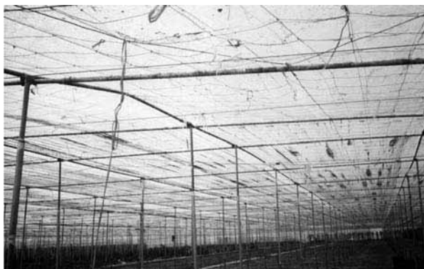
Figura 20. Interior de un antiguo invernadero plano con estructura metálica
