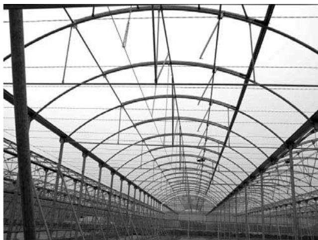
Figura 28. Estructura de un invernadero multitúnel de cubierta cilíndrica
