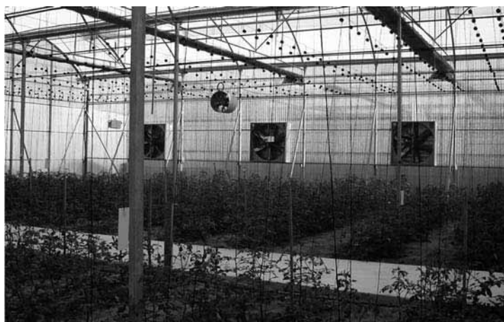
Figura 59. Vista de los extractores situados en la banda opuesta al panel evaporador
