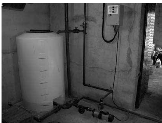
Figura 109. Sistema de fertirrigación mediante depósito de aspiración directa mediante bomba
