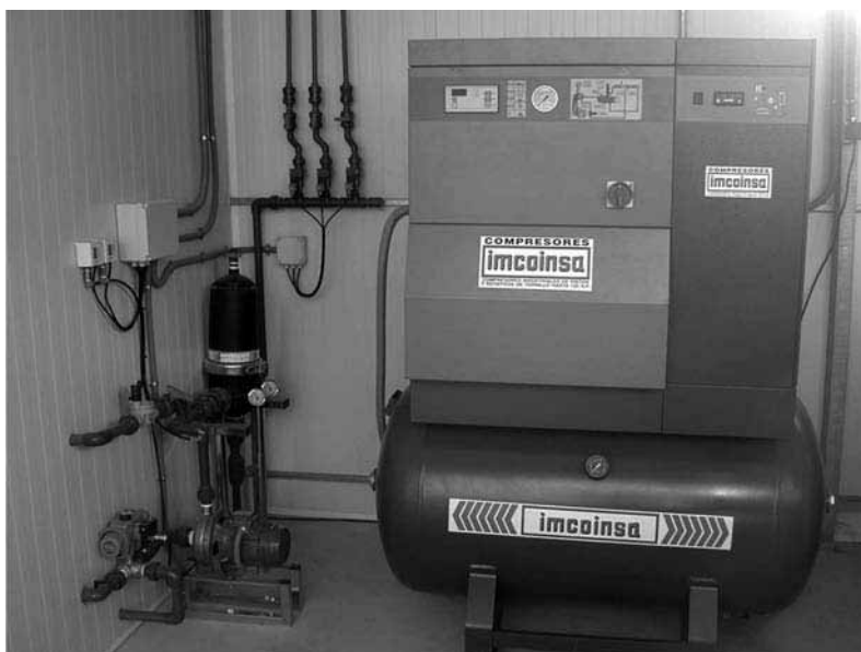
Figura 64. Compresor de aire y bomba de impulsión del agua en una instalación de nebulización
