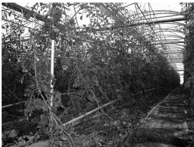
Figura 85. Sistema de calefacción mediante tuberías de agua caliente de aluminio situadas a la altura del cultivo
