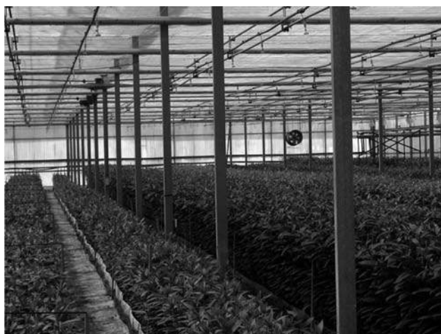
Figura 92. Invernadero con pantallas térmicas aluminizadas
