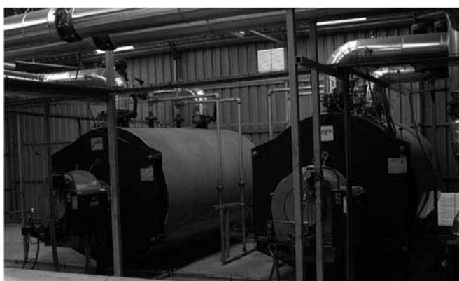
Figura 87. Instalación de calefacción en invernaderos de Almería con dos calderas para generación de agua caliente
