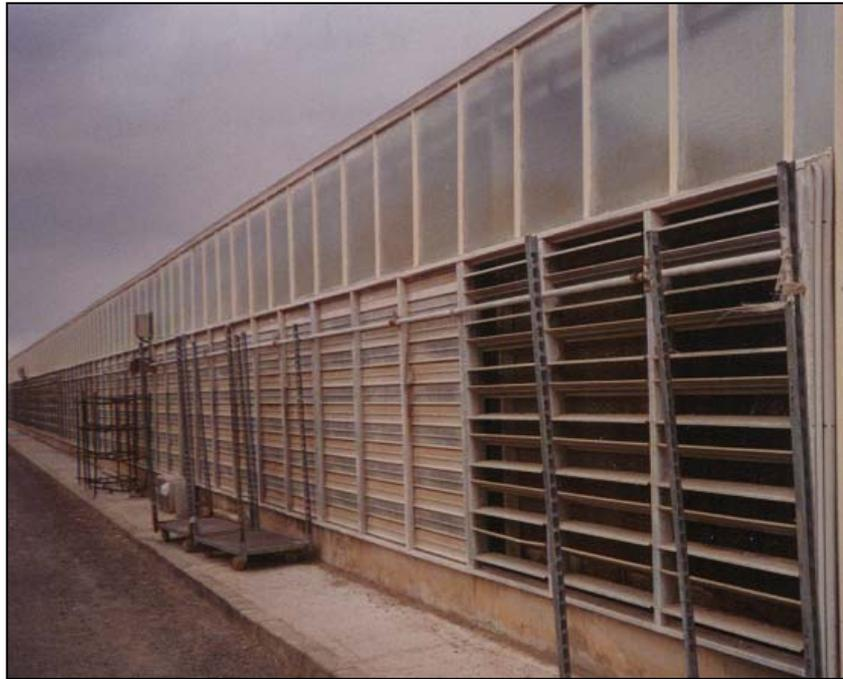
**Figura 54. Paneles evaporadores con protección exterior.**
